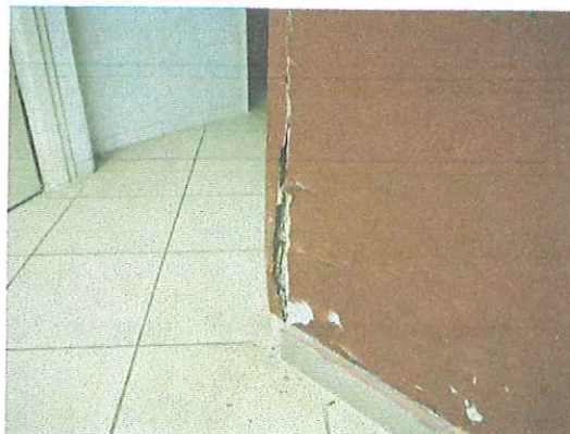
Fot. 8 – zawilgocenie ściany w rejonie przyziemia; ościeże drzwiowe uszkodzone przez nasiąkanie wodą, a następnie zamarzanie i rozmarzanie ściany
