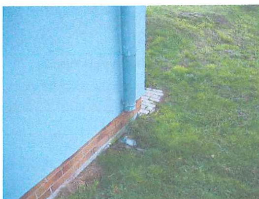
Fot. 3 – brakujący fragment rury spustowej
