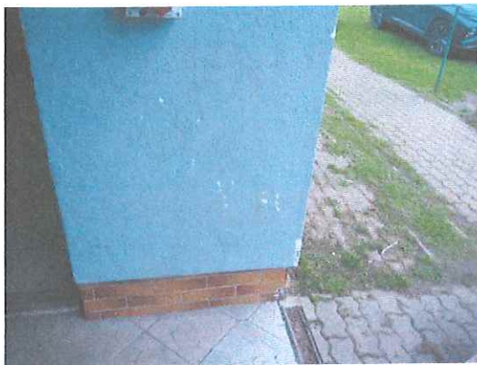
Fot. 1 – lokalne ubytki tynku elewacji
