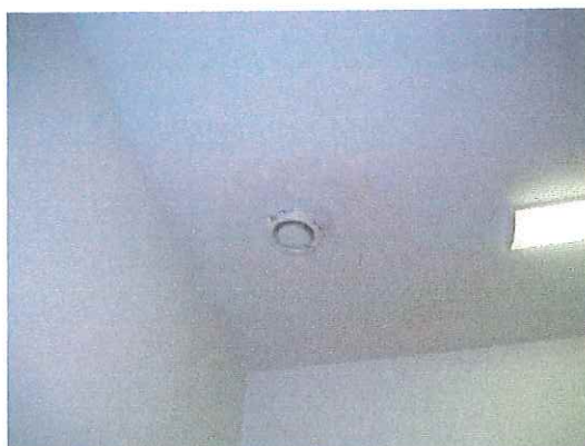
Fot. 5 – zawilgocenie sufitu w rejonie kanałów wentylacyjnych
