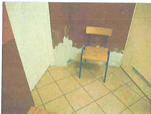
Fot. 7 – zawilgocenie ścian w rejonie przyziemia – doraźnie zamaskowane uszkodzenia tynku
