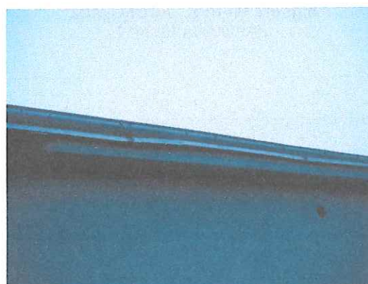
Fot. 4 – uszkodzona obróbka blacharska
